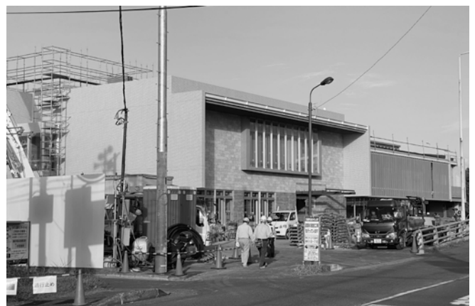
▲工事中の希望の郷交流センター
