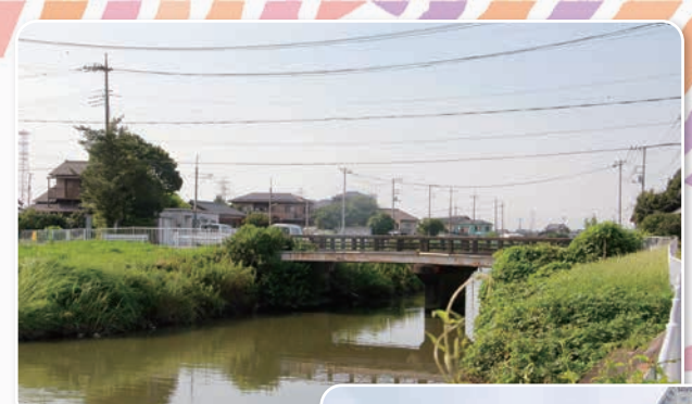
▲越谷流山線の道路にかかる小谷堀橋
